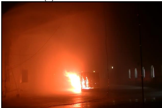
(d) 120 s after activating FFFS
