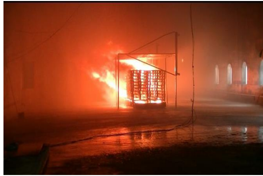
(d) 120 s after activating FFFS
