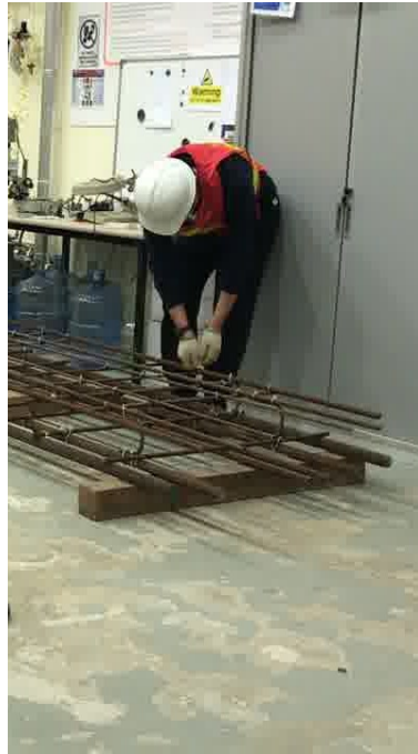
e. Tying Rebar
