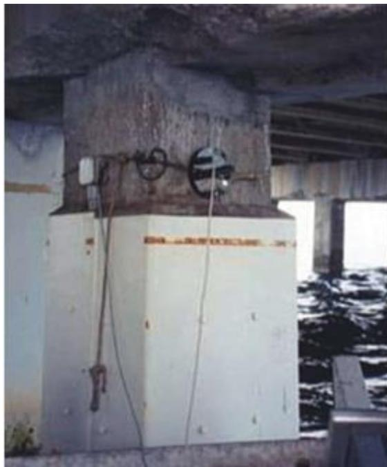
(d) Sacrificial metal connected to an RC bridge pier
