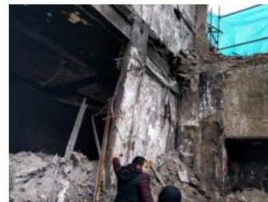
(d) Measurement of column distances using laser meter.
