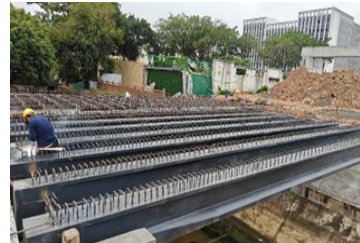
(d) Main beam structure.
