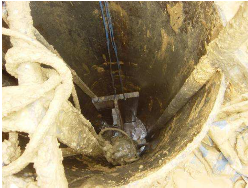
(d) Embedding and grouting the H-shaped steel
