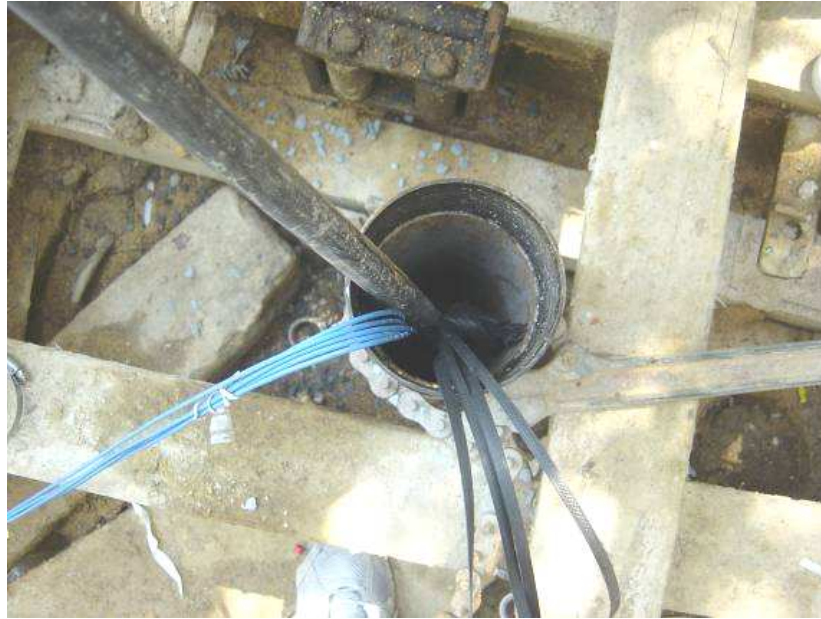
(d) Grouting of the drillhole
